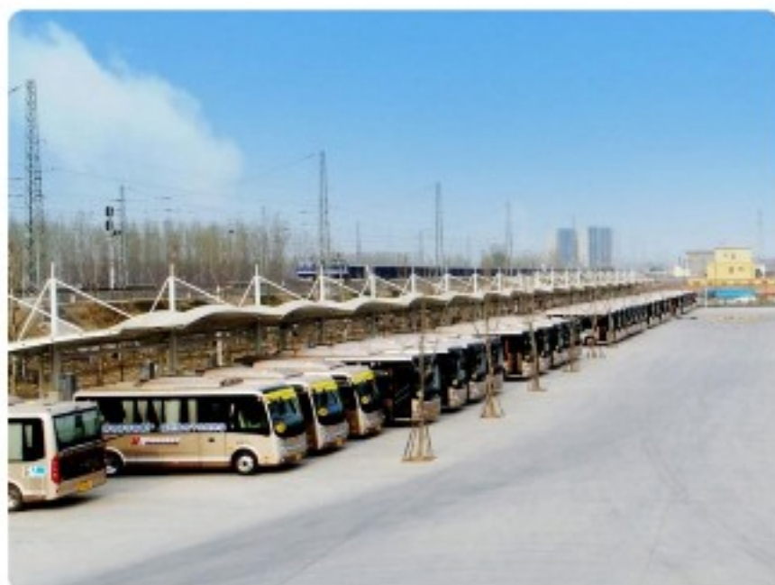
山东公交充电项目
