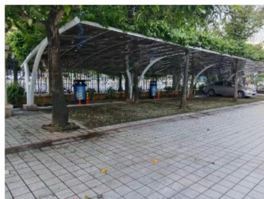
惠州小区充电项目
